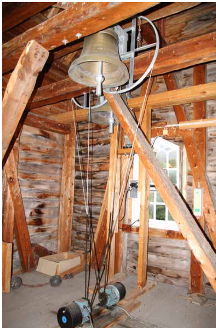
Her ser vi korleis klokkene er plassert i tårnet, med dei elektriske motorane på golvet og ei overføring derifrå til store hjul som svingar klokkene.
