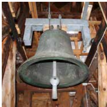
Storeklokka har fått ny kolv. Med motvektar i toppen er det lett å setja klokka i rørsle, og ikkje minst: stogga henne!
